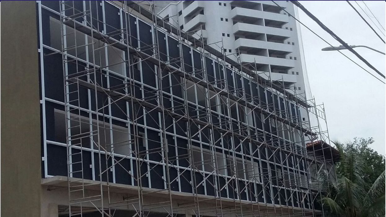
Instalação de perfis linha pele de vidro com andaime fachadeiro
