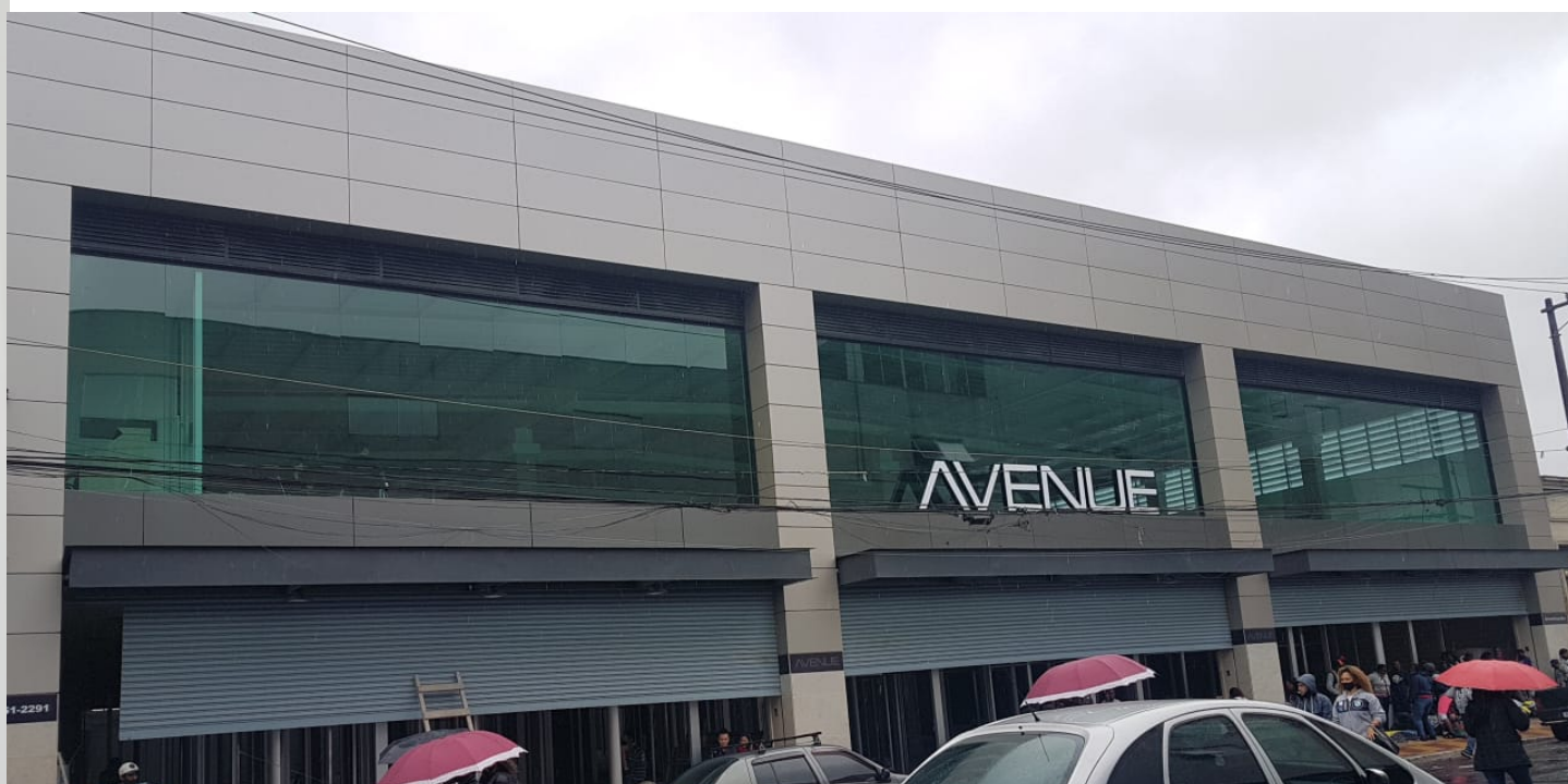
Revestimento de Acm 4mm em formato de bandeja e Vidro temperado 10mm verde
