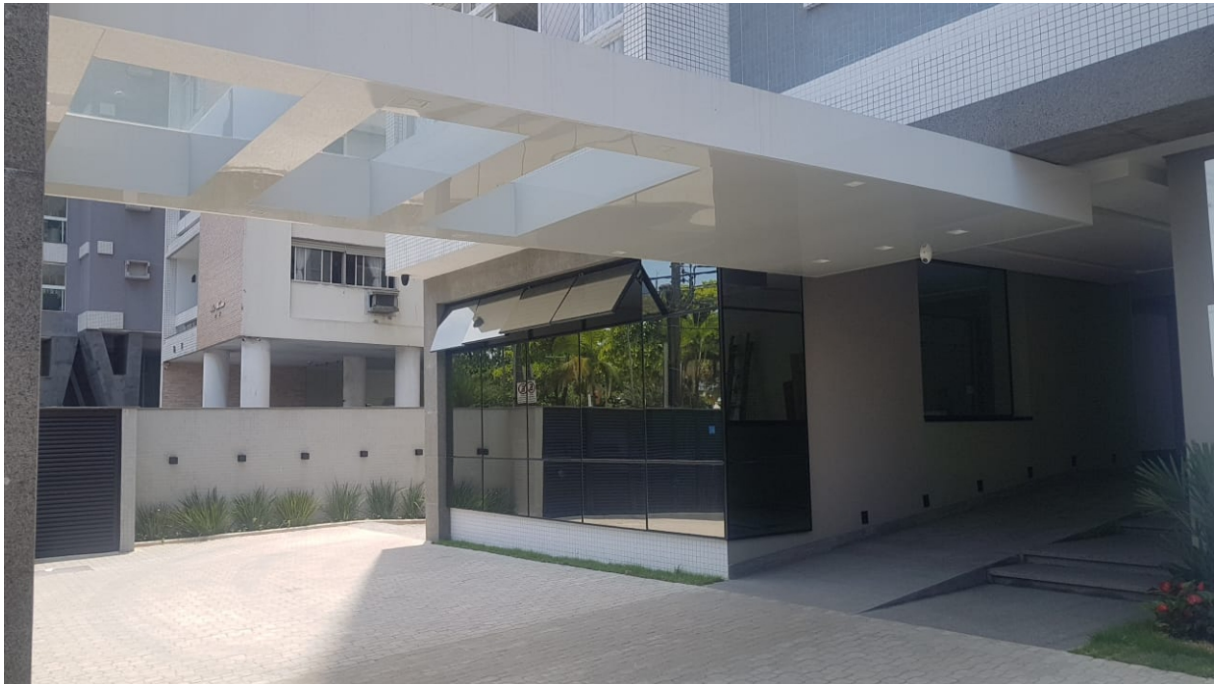
Cobertura em estrutura metálica com pergolado em acm e vidro transparente
