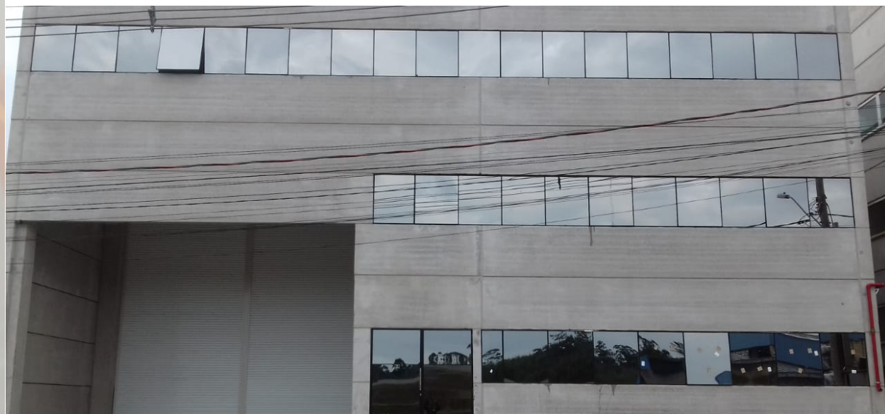
Fachada Pele de Vidro em Galpão Pré Moldado
