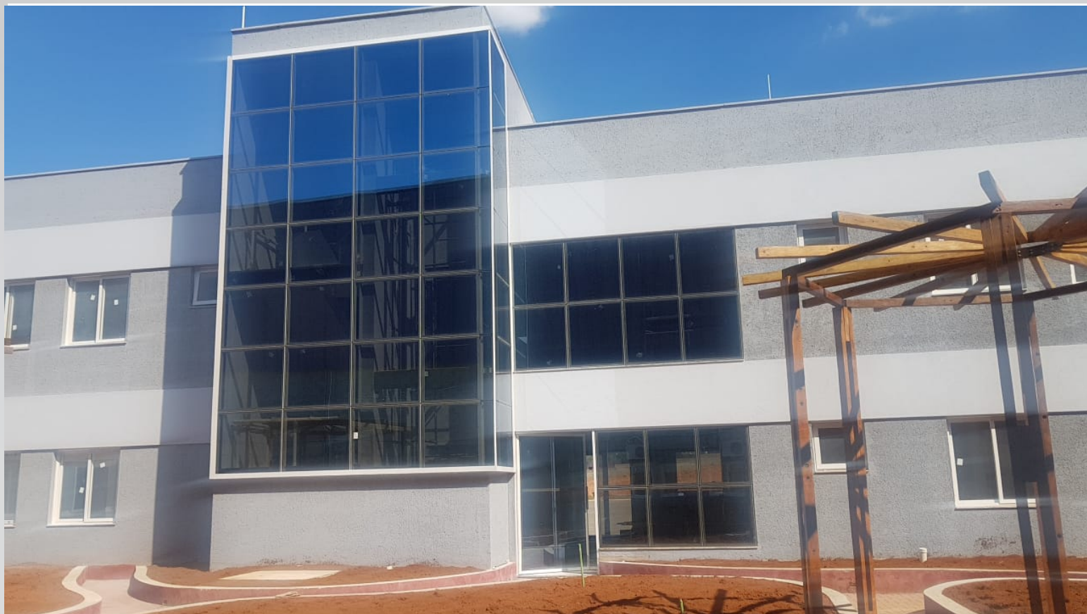
Pele de Vidro em Caixa de Elevador e Escada
