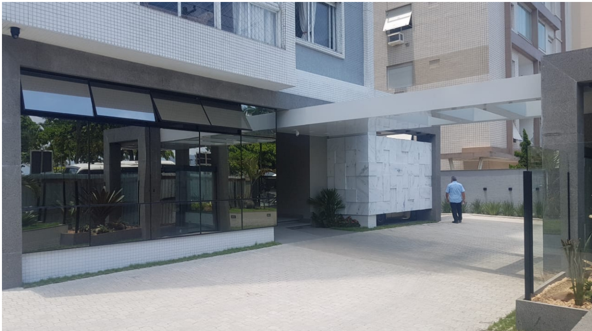
Cobertura e Pele de Vidro para Portaria de Predio Residencial
